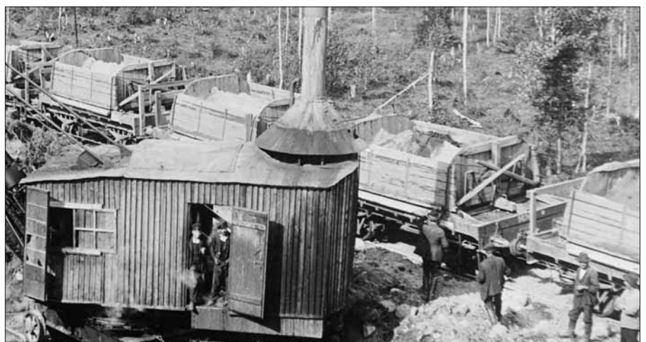
Wäinö Rankan vaunut näkyvät vanhoissa valokuvissa hyvin vaaleina. Tämä johtuu todennäköisesti siitä, että vaunut on tervattu vaaleanruskealle tervalla. Kuva: Museovirasto.
